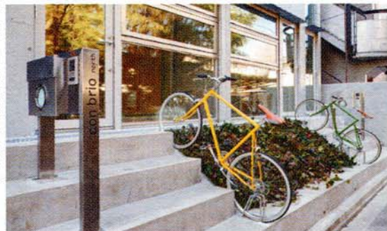
▲駐輪スペースを階段に合わせてデザインしている
